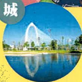
西屯區中央公園
