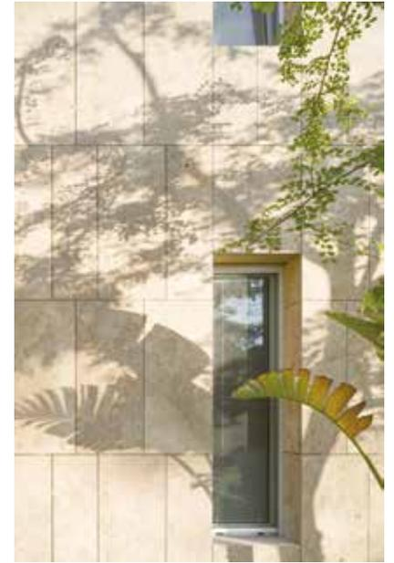
二層退縮為兩間臥房及東側、南側的露台，與地面層之前院連接成一個立體的戶外生活空間。外牆面材採用洞石，皮革般的色澤及自然如雲霧般的紋理，在陽光的照射下，產生如土壤般的質感，不規則的分割與大小不一的開口，如音律般跳動，建築量體簡單但有力的嵌合於大地之上。
